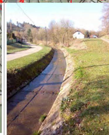
Obrázek 1 V horní části obce je koryto zkapacitněno, napříměno a opevněné ŽB panely.
