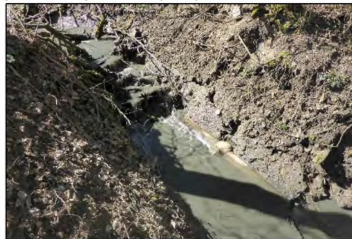
obr. 2 - Fotodokumentace zarostlého vtoku do zatrubnění erodovaného koryta Praha 5 - Smíchov, 150 56 Nábřeží 4, Tel.: 257 110 111, http://www.vrv
