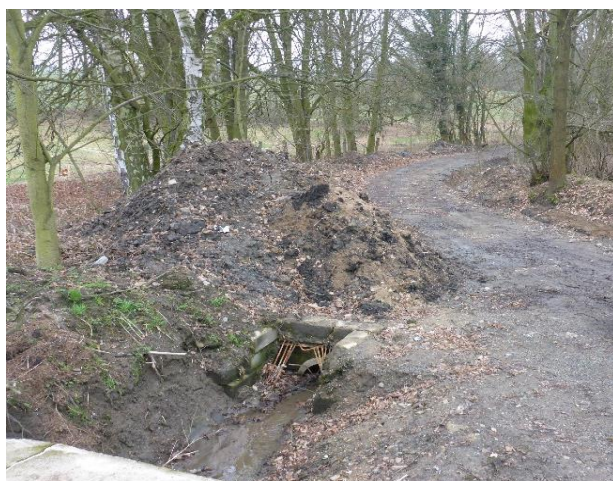
Částečně zazemněný propustek a koryto bezejmenné vodoteče.
