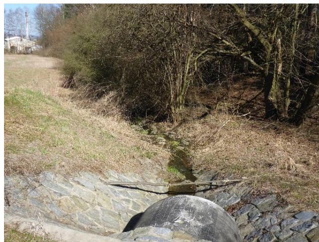
Vyústění propustky pod bývalým železničním náspem nad KB.
