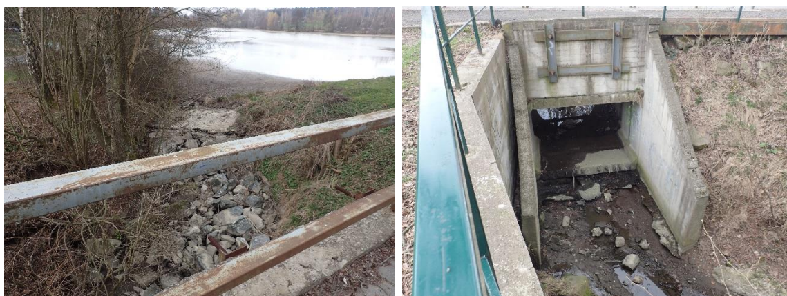
Rybník Požár, vlevo bezpečnostní přeliv, vpravo propustek pod silnicí a odtokové koryto
