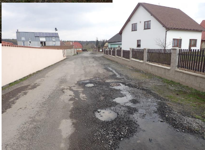
závěrový profil mířící do zástavby a vývěr vody, kterou za povodní nepobere kanalizace
