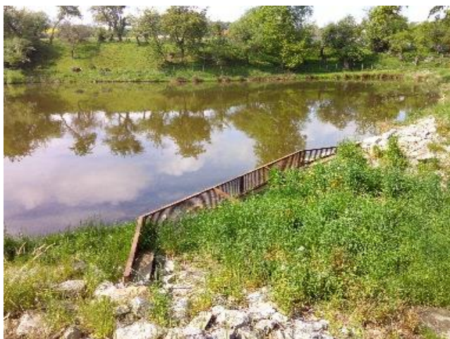
Hráz Kněžského rybníka s funkčním pezepečnostním přelivem.
