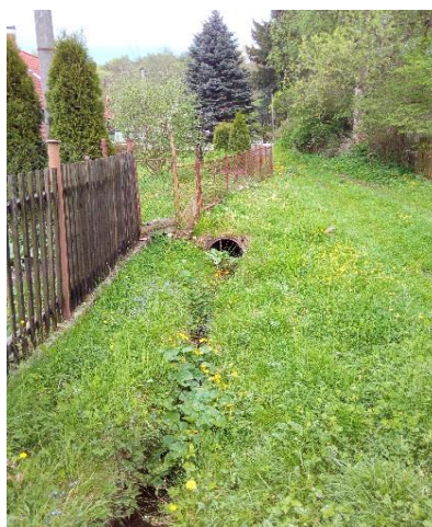
Nekapacitní vtok zatrubnění.
