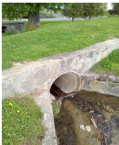
Propustek pod korunou hráze u sdruženého objektu
