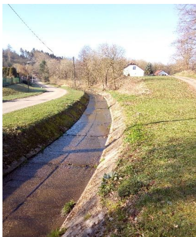
V horní části obce je koryto zkapacitněno, napříměno a opevněné ŽB panely.
