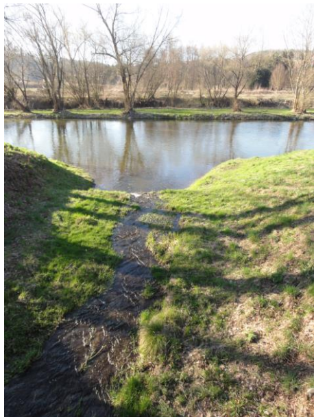
Dojetřický potok – nevhodná profilace a nízká kapacita koryta v intravilánu
