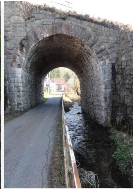
Dojetřický potok – nevhodná profilace a nízká kapacita koryta v intravilánu
