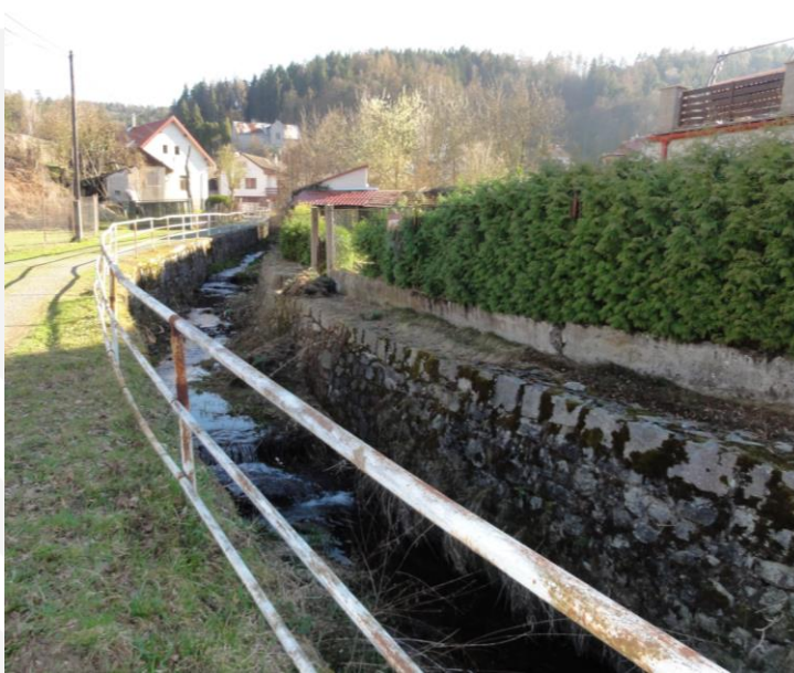
Dojetřický potok – nevhodná profilace a nízká kapacita koryta v intravilánu
